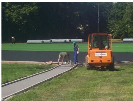
eingebaut war, zunächst auf einer Tragschicht, dann auf einer Elastischschicht aufgebracht. So entstand dann eine neue Kunstrasenfläche von insgesamt 6.336 m<sup>2</sup>. Dazu kamen noch 324 m Muldenrinne, das Anlegen eines neuen gepflasterten Weges von den Umkleidekabinen zum Platz und diverse Erdarbeiten sowie der Einbau neuer Fußballtore und Eckfahnen.
